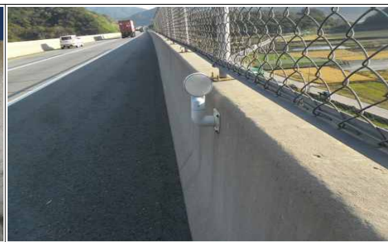
하행선 S10 텔리네이트 보수 현황
