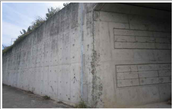
콘크리트 옹벽 S1 콘크리트 들뜸 보수
