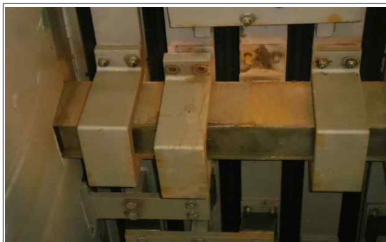
상행선 P2 신축이음 지지대 탈락 및 진동 발생
