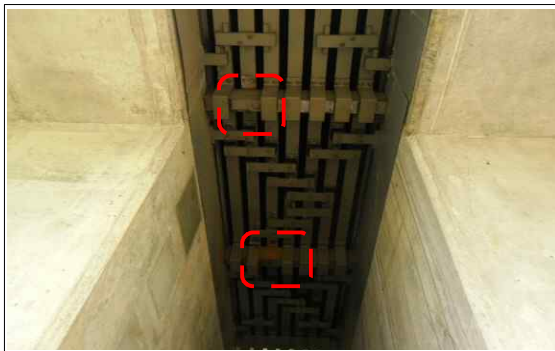
상행선 P2 신축이음 Support Beam 지지대 탈락 및 진동 발생
