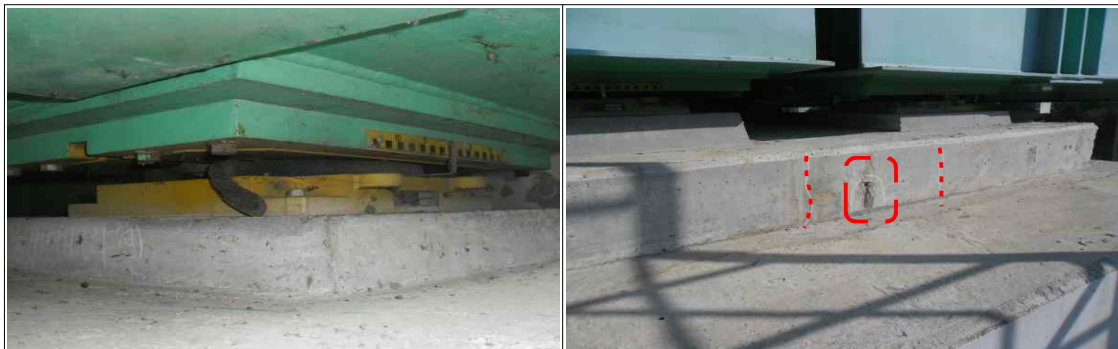
하행선 P3 SH1, SH5 받침콘크리트 균열(폭0.1mm) 및 파손
