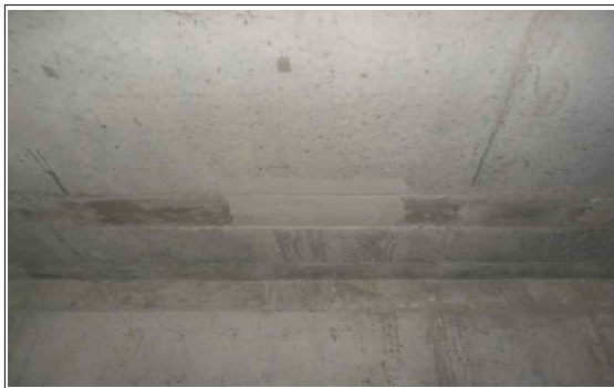
상행선 S5 주형내부 상면 백태 보수
