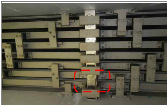
상행선 P2 신축이음 Support Beam 지지대 탈락 및 진동 발생
