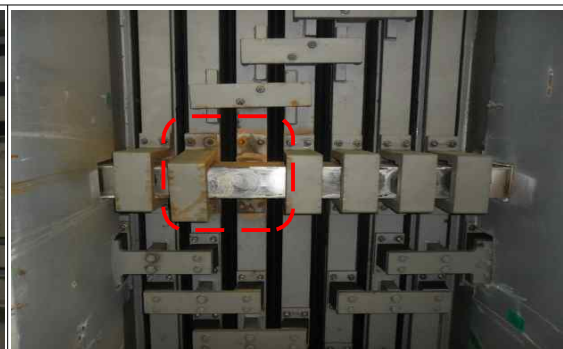
상행선 P2 신축이음 Support Beam 지지대 탈락 및 진동 발생
